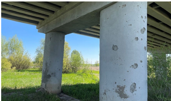
Рисунок 1 — Осколкові ураження стійок опори
