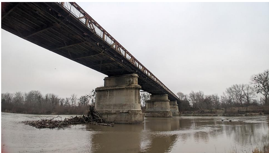
Рисунок 7 — Фасад мосту через р. Прут у м. Чернівці
