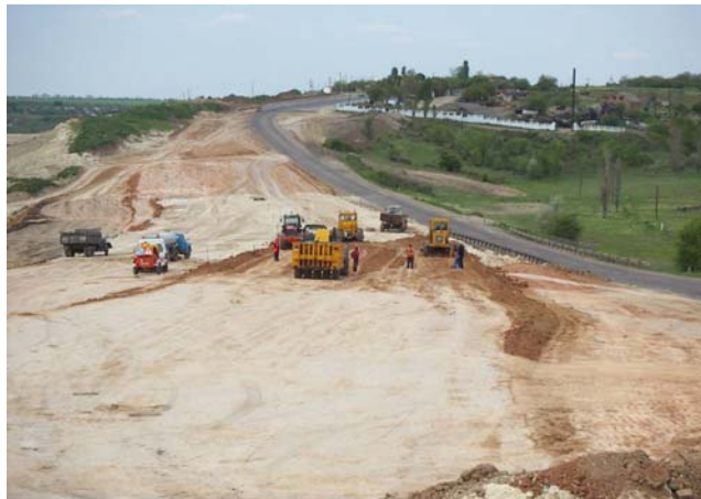
Рис. 2. Загальний вигляд першої дослідної ділянки, нівелювання осадок ґрунту при ущільненні по металевим маркерам
