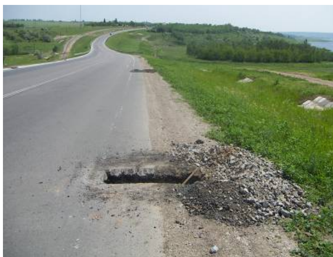
Рис. 4. Влаштування шурфу для визначення щільності та вологості ґрунту на дослідних ділянках (№2 і №3) автомобільної дороги Ульянівка-Миколаїв, км 150+365 – км 151 +645
