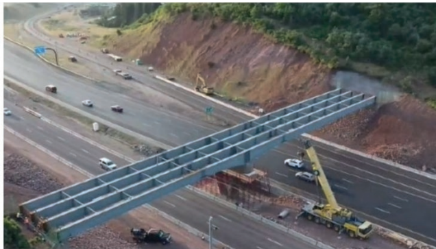
Рисунок 4 — Будівництво екодука в штаті Юта
