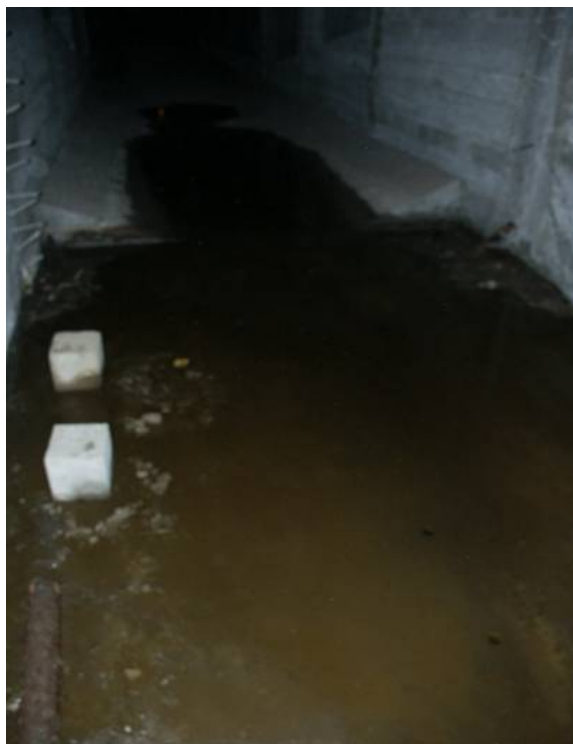
Рис. 7. Руйнування конструкцій деформаційних швів типу „ковзний лист” (а, б), вилугування бетону, руйнування торців балок (в), застої води в закритих коробках прогонових будов (г)
