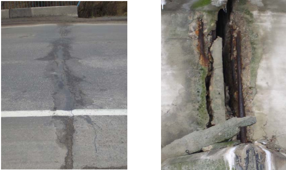
Рис. 3. Розладнання деформаційного шва закритого типу (а) та його наслідки (б): руйнування бетону торців балок та в місцях встановлення опорних частин, руйнування опорних частин, корозія арматури
