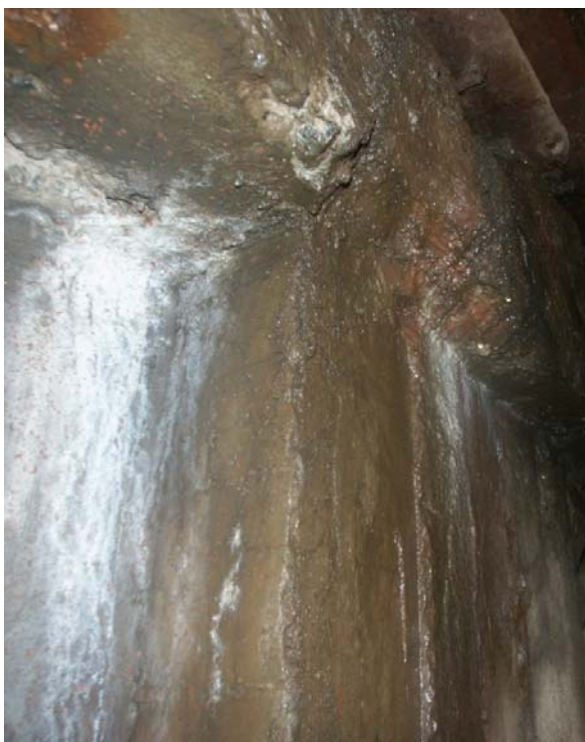
Рис. 7. Руйнування конструкцій деформаційних швів типу „ковзний лист” (а, б), вилугування бетону, руйнування торців балок (в), застої води в закритих коробках прогонових будов (г)
