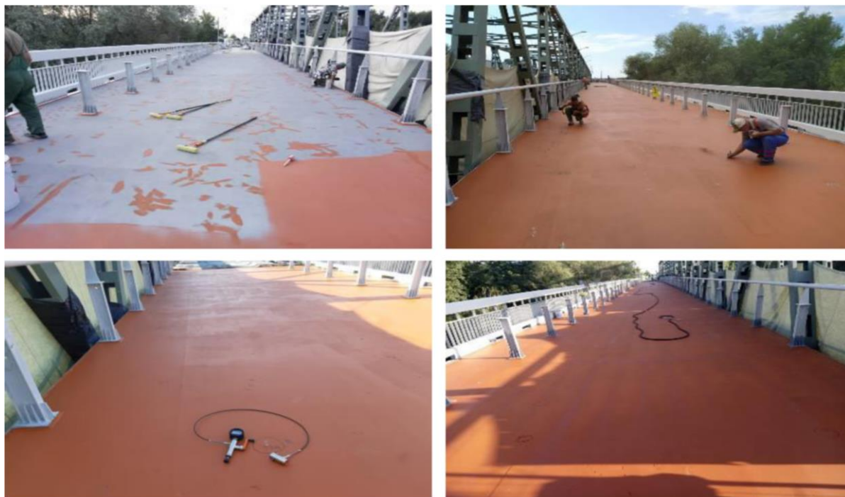
Рисунок 7 — Аварійно – відновлювальні роботи на мості на автомобільній дорозі М-06 Київ-Чоп км 831+711 через р. Тису, Закарпатська область, Україна, 2021 р. [1]
