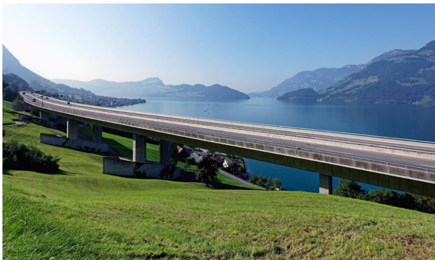
Рисунок 3 — Віадуку Беккенрід-Ленен, Швейцарія [4]
