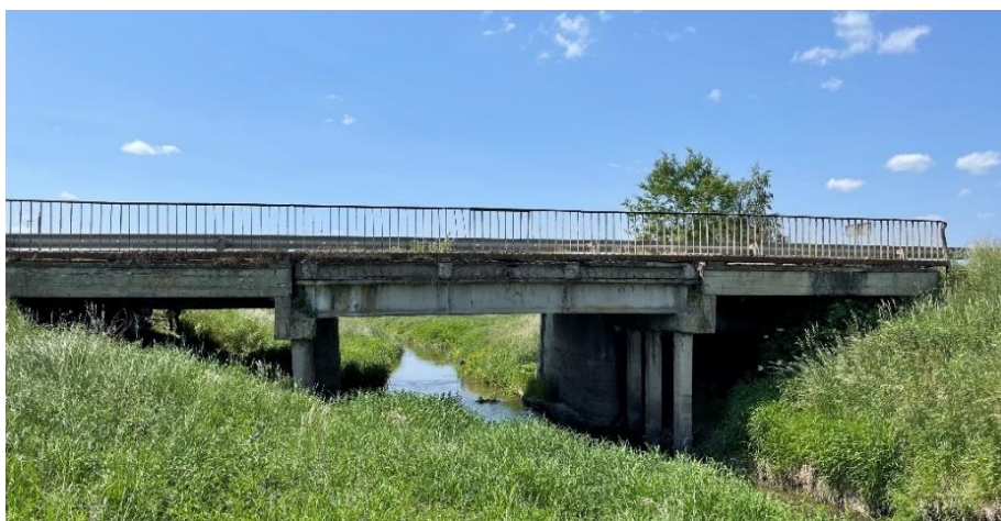
Рисунок 2 — Загальний вид залізобетонного мосту
