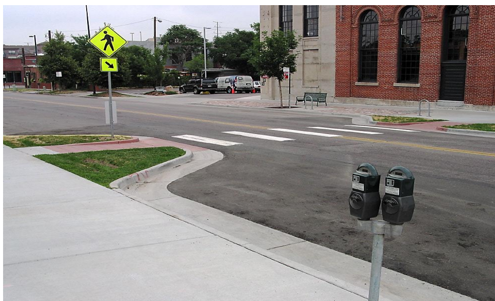
Рисунок 13 — Приклад улаштування чокера [7]
