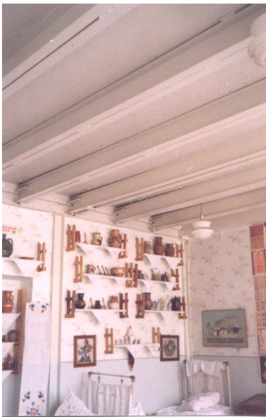
Рис. 1. Загальний вид підсилених будівельних конструкцій стін і перекриття
