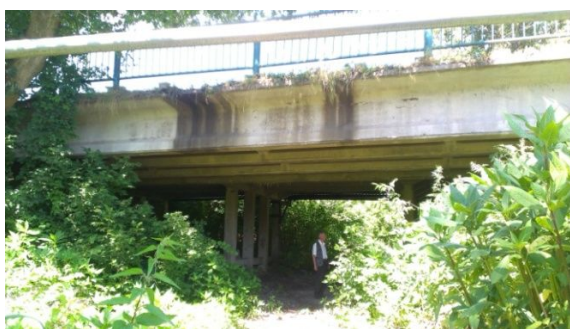
Рисунок 1 – Загальний вигляд мосту
