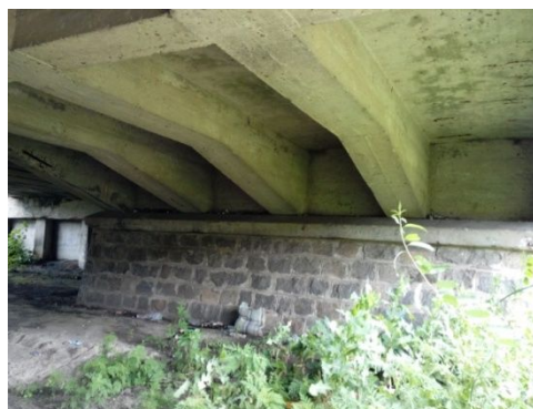
Рисунок 10 – Опора і прогонова будова
