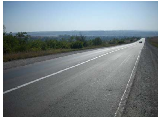
Рис. 6. Використання каучуко-бітумної стрічки на стику суміжних смуг асфальтобетонного покриття по осі дороги Улянівка-Миколаїв
