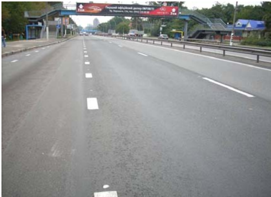
Рис. 5. Використання каучуко-бітумної стрічки на стику суміжних смуг асфальтобетонного покриття на автомобільній дорозі Київ-Чоп, км 14 – км 18, станом на 16.09.08
