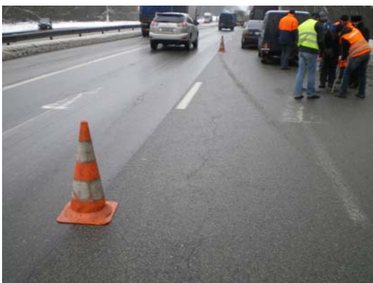
Рис. 7. Стан каучуко-бітумної стрічки на стику суміжних смуг асфальтобетонного покриття на автомобільній дорозі Київ-Чоп, км 14 – км 18, станом на 11.02.10 без
