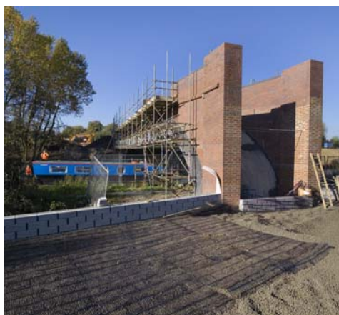
Рис. 7. Общий вид конструкции моста
