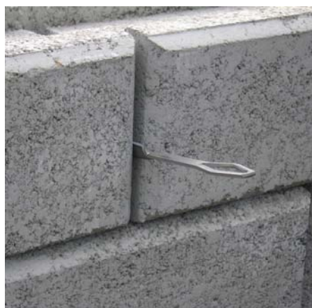
Рис. 8. Соединитель (затяжка) из нержавеющей стали вблизи
