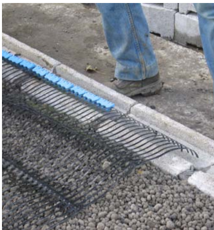
Рис. 5. Закрепление лицевой стороны решетки полимерными соединителями
