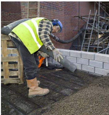
Рис. 6. Пневматическая подача керамзита перед уплотнением
