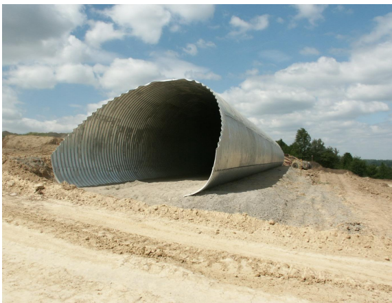
Рисунок 1 – МГК в стадії будівництва на автомобільній дорозі "Київ-Одеса"
