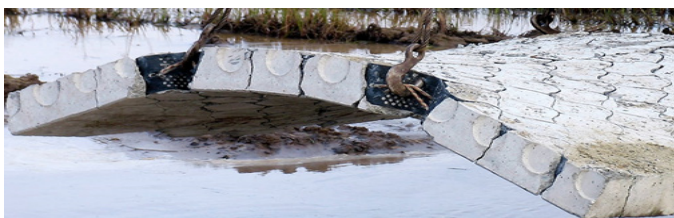
Рисунок 3 — Гнучка бетонна плита, для дорожнього й аеродромного будівництва
