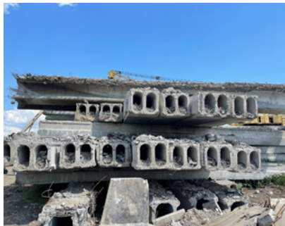
Рисунок 1 — Пошкодженні плити прогонової будови за типовим проєктом ВТП-21 внаслідок воєнного вторгнення
