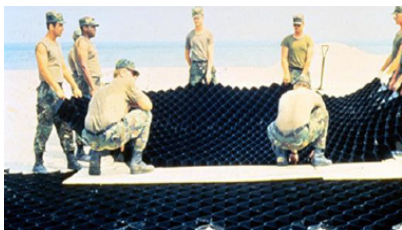
Рисунок 1 — Застосування георешіток для швидкого забезпечення руху військової техніки
