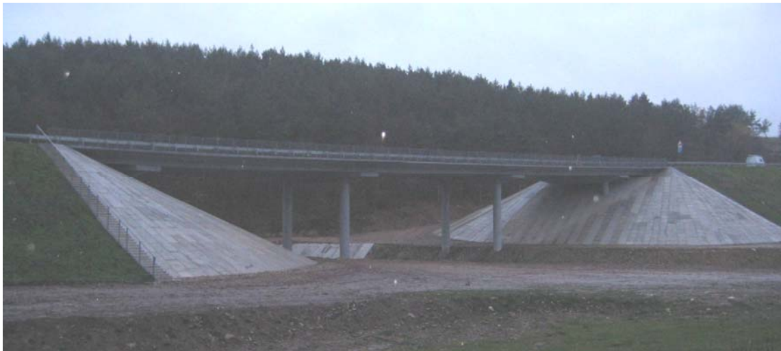
Рис. 1. Загальний вигляд моста
