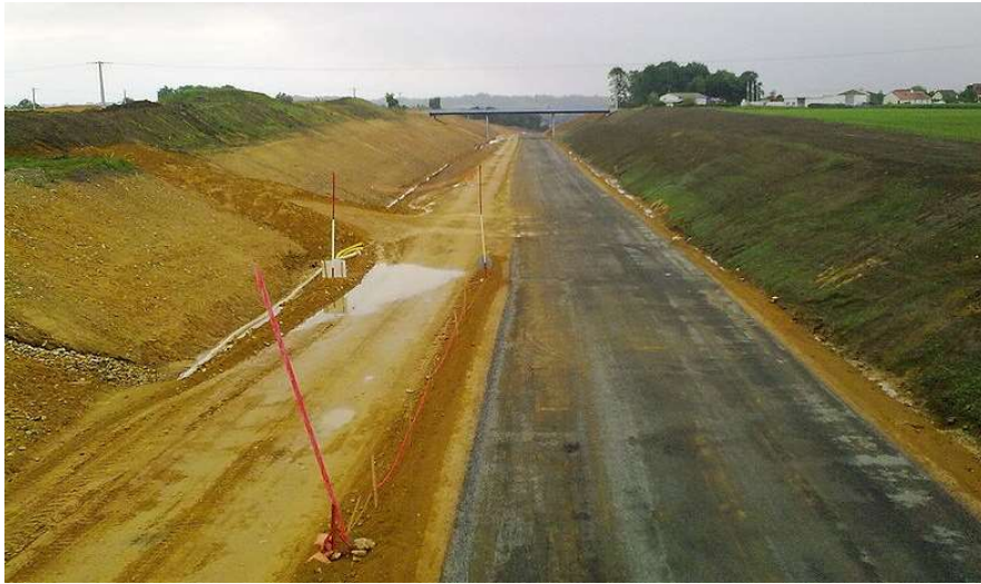
Рисунок 8 — Автомагістраль А-65 будівництво, червень 2010 року
