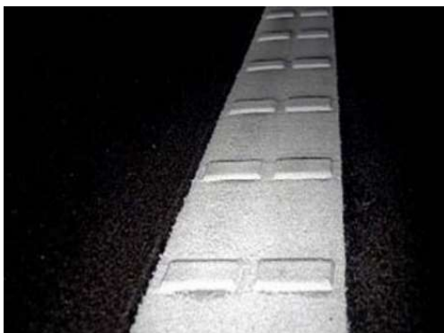
Рисунок 4 – Приклади поздовжніх шумових смуг, виконаних з пластичних матеріалів для дорожньої розмітки
