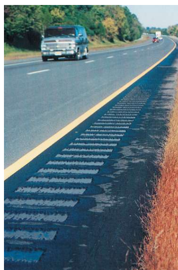
Рисунок 5 – Поздовжні шумові смуги, влаштовані способом фрезерування
