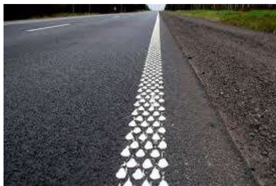
Рисунок 4 – Приклади поздовжніх шумових смуг, виконаних з пластичних матеріалів для дорожньої розмітки
