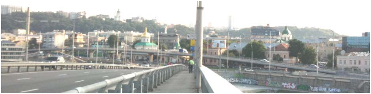
Рис. 1. Естакада на вул.Набережно-Хрещатицькій у м. Київ
