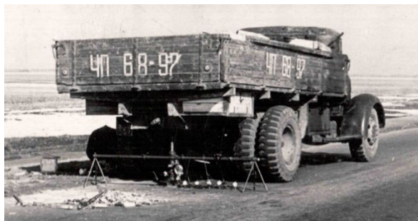
Рисунок 2 – Оцінка статичної чаші прогину проф. Біруля О.К. при поступовому прикладанні навантаження, 50-ті роки ХХ ст
