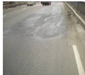
Рис. 3. Південний мостовий перехід (естакадна частина), обстеження 2011 р.
