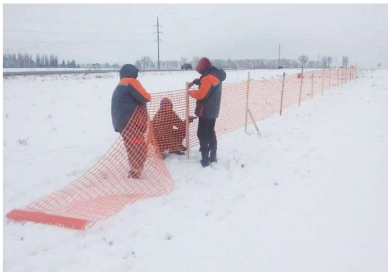
Рисунок 1 — Встановлення полімерних сіток
