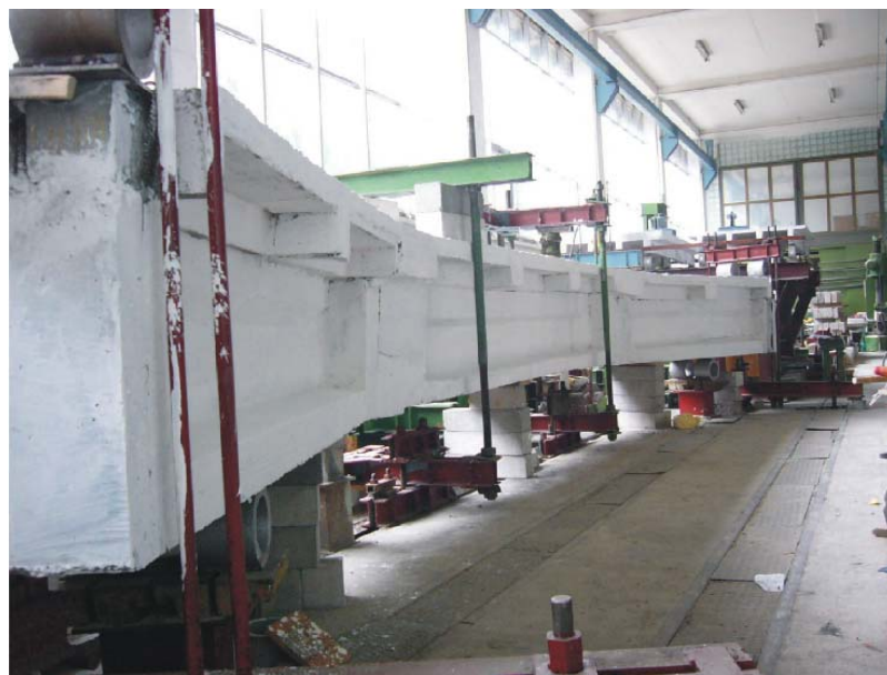
Рис. 8. Загальний вигляд дослідної конструкції прогонової будови естакади на кривій на випробувальному стенді
